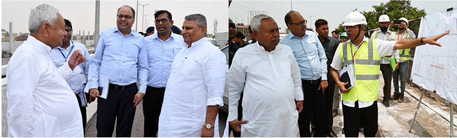
पथ शामिल है। निर्माण कार्य 2 फेज में किया जा रहा है। पहले फेज के निर्माण
